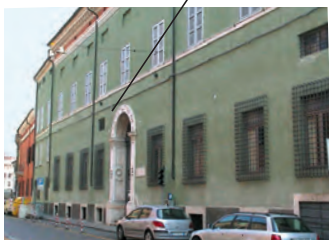
La scuola elementare in via Chiassi
